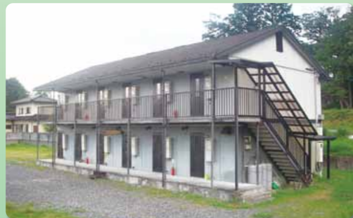
▲居宅生活訓練事業用住宅 泉荘(兼 グループホーム)
