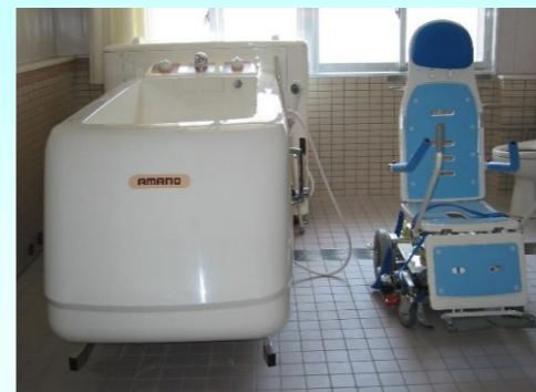
北棟特殊浴槽
